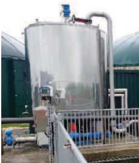
Figure 2 : Exemple de cuves d'hygiénisation (source : AES DANA)
