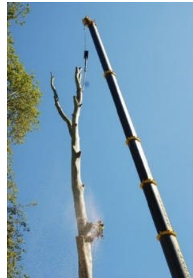
Démontage de la chandelle
