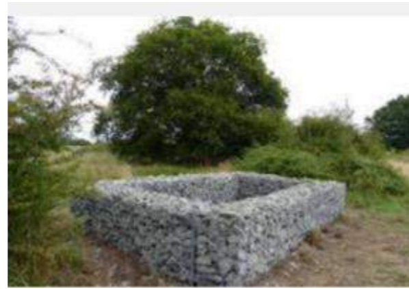
Figure 19. Exemple de gîte à reptiles encerclé de gabion - @Amphibiens-reptiles-bocage
