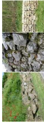
Exemple de murets et de gabion favorables au lézard des murailles
