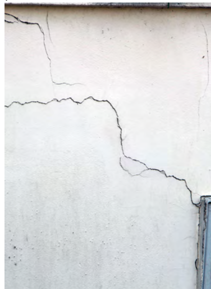
Déformation d'un bâtiment par tassement différentiel
