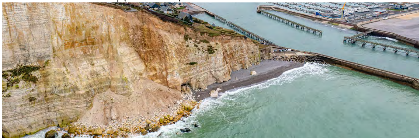
Effondrement de falaise à Fécamp (Seine-Maritime)
