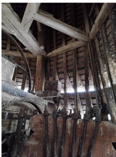
Aperçu des grillages anti volatiles mis en place
