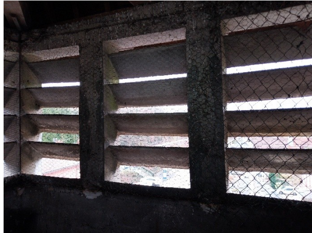
Vue des abat-sons équipés de grillages anti volatiles (Source : F.X. PLAISANT, GONm le 12-03-2025)
