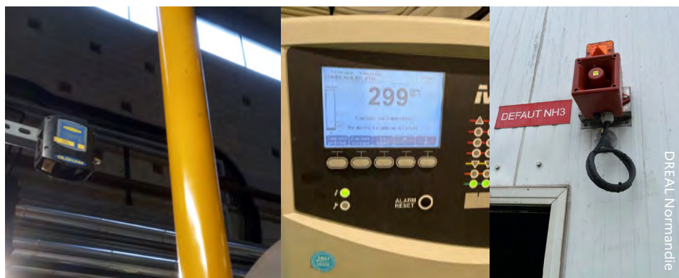
Photo, de gauche à droite : détecteur gaz, concentration du détecteur à la centrale de détection et alarme en cas de dépassement des seuils
