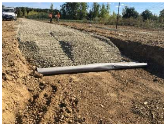
Figure 20 : Exemple de réalisation de voie d'accès interne
