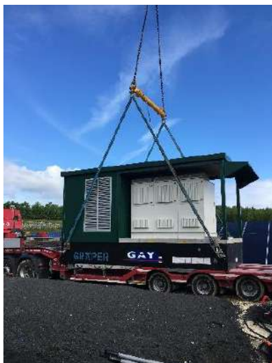
Figure 26 : Livraison d'un poste électrique
