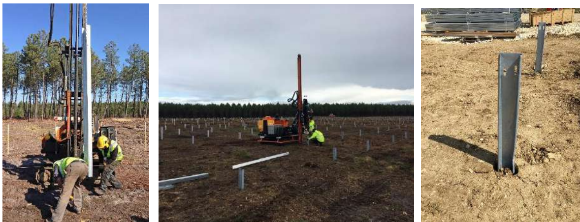
Figure 22 : Exemple de pieux battus et de leur mise en place sur les chantiers URBASOLAR
