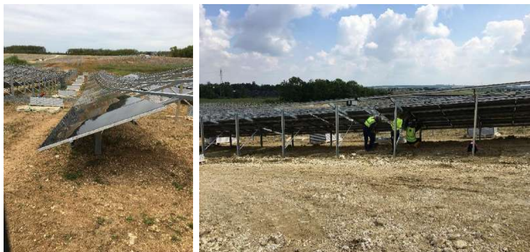
Figure 25 : Exemples de mise en place de panneaux sur les chantiers URBASOLAR
