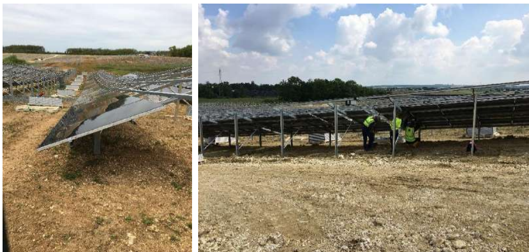
Figure 29 : Exemples de mise en place de panneaux sur les chantiers URBASOLAR
