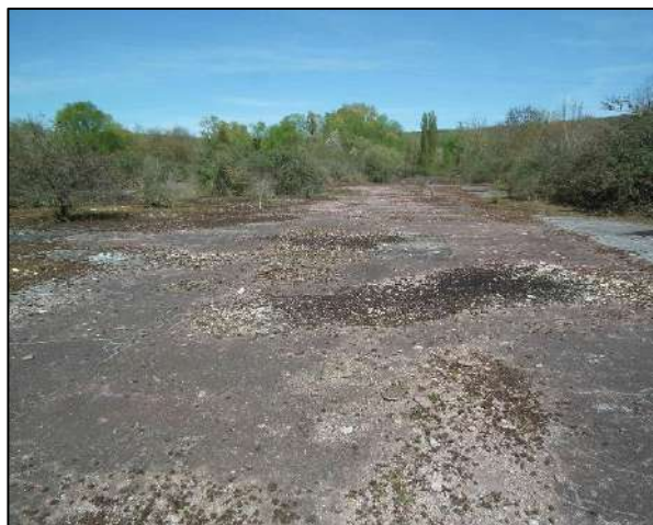
Figure 46 : Dalle goudronnée (= Friche industrielle)
