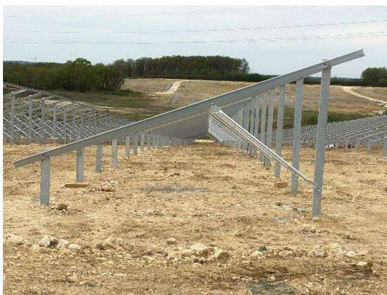
Figure 23 : Exemple d'une structure porteuse complète avant mise en place des panneaux
