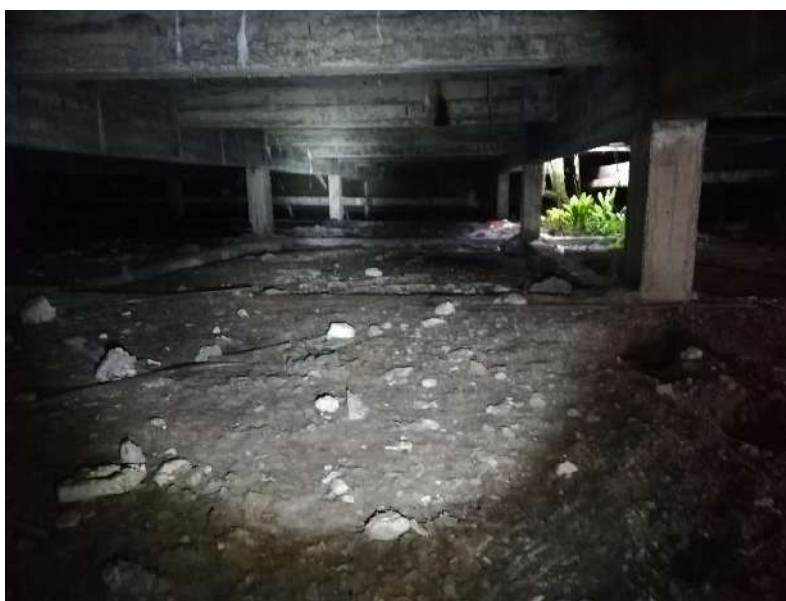
Figure 59 : Dalle de béton, vue du dessous
