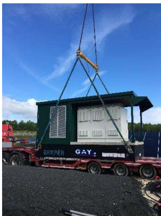
Figure 30 : Livraison d'un poste électrique
