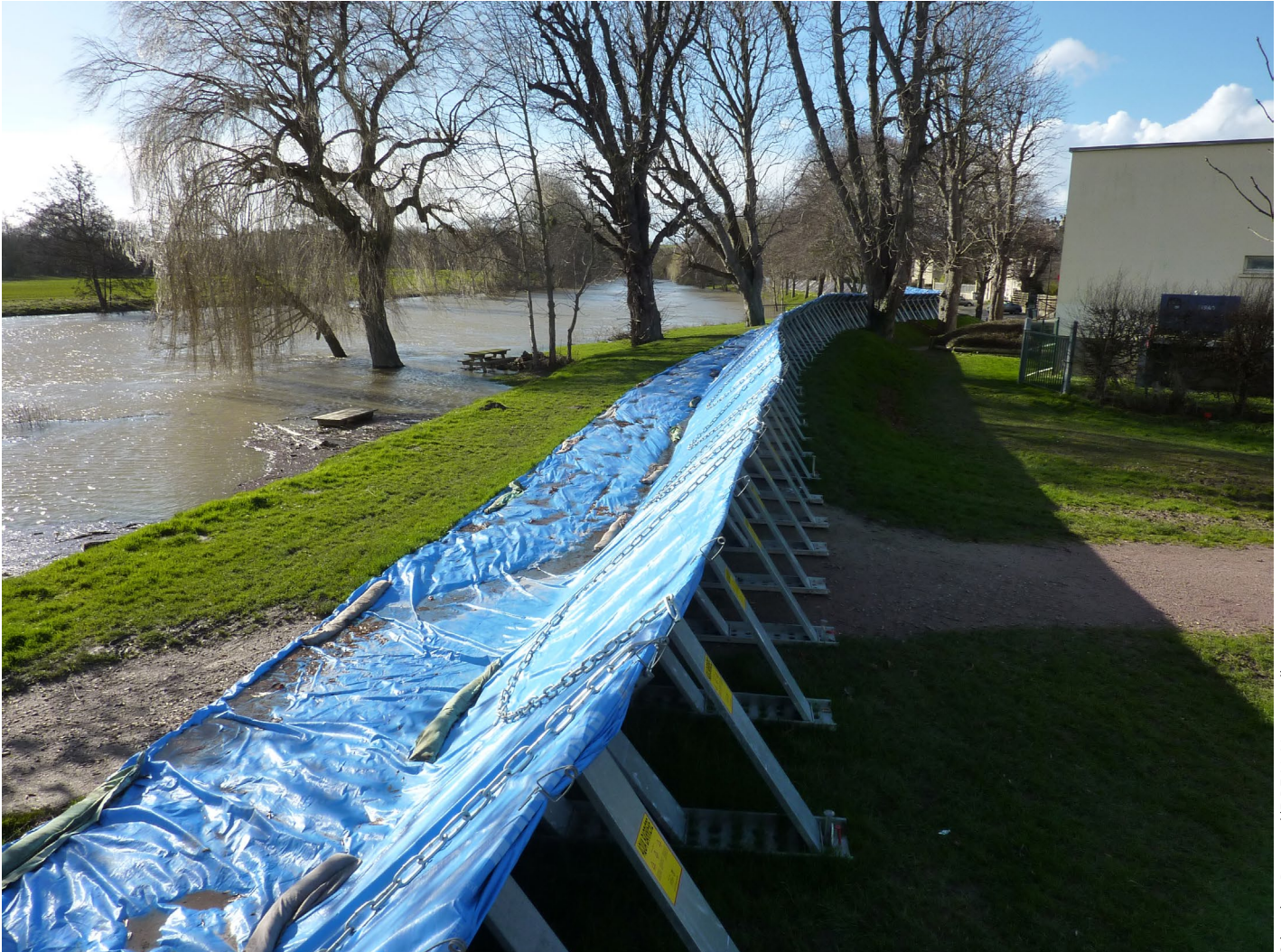
Aqua barrières de Louvigny pour faire face au débordement du cours d'eau
