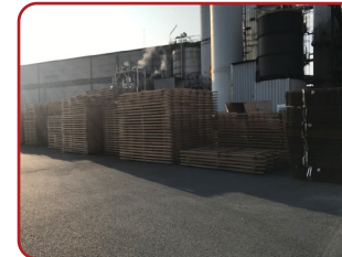
Stockages de palettes en limite de site
