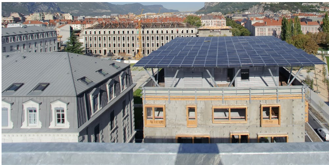
Centrale solaire photovoltaïque d'un bâtiment à énergie positive.
