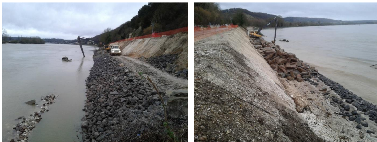
Vues des travaux réalisés en 2018
