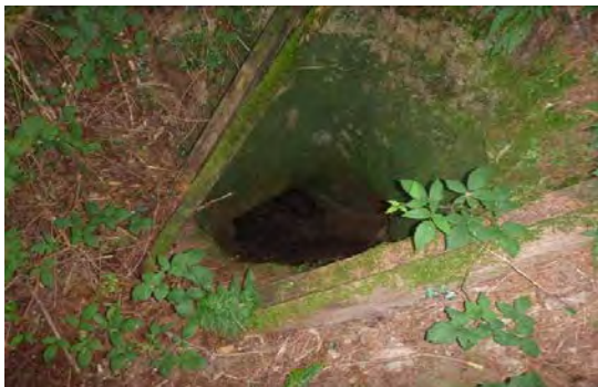
Photo 33 : Cheminée d'aérage N°1 de Bousentier
