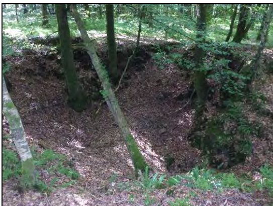
Photo 3 : Fontis Descenderie N°3 de Berdallier
