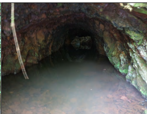
Photo 2 : Intérieur du travers-banc (GEODERIS)
