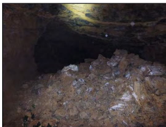
Photo 42 : Remontée de voûte
