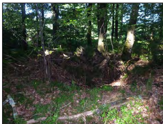
Photo 9 : Fontis Berdallier N°9 remblayé avec des souches
