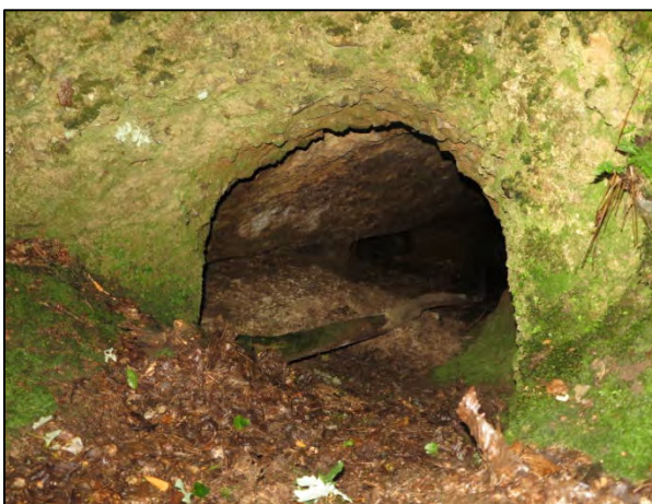
Photo 7 : Montage ouest (GEODERIS)
