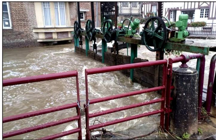
La Vie en crue dans la traversée de Vimoutiers (61, quelques km en aval de Guerquesalles) le 12 juin entre 11h et 12h, le pic de crue est déjà passé, les niveaux sont à la baisse. A gauche, les quais de la Vie le long des Halles. A droite les vannes du moulin, levées au plus haut, disparaissent presque sous les eaux. - Source : DREAL Normandie/SRN/B2HPC
