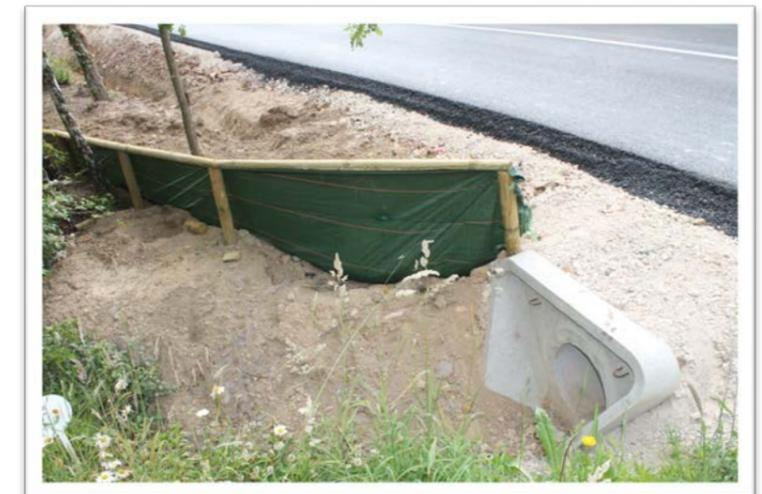
Photo 4 : exemple de clôture « anti-amphibien » réalisée sur une opération similaire
