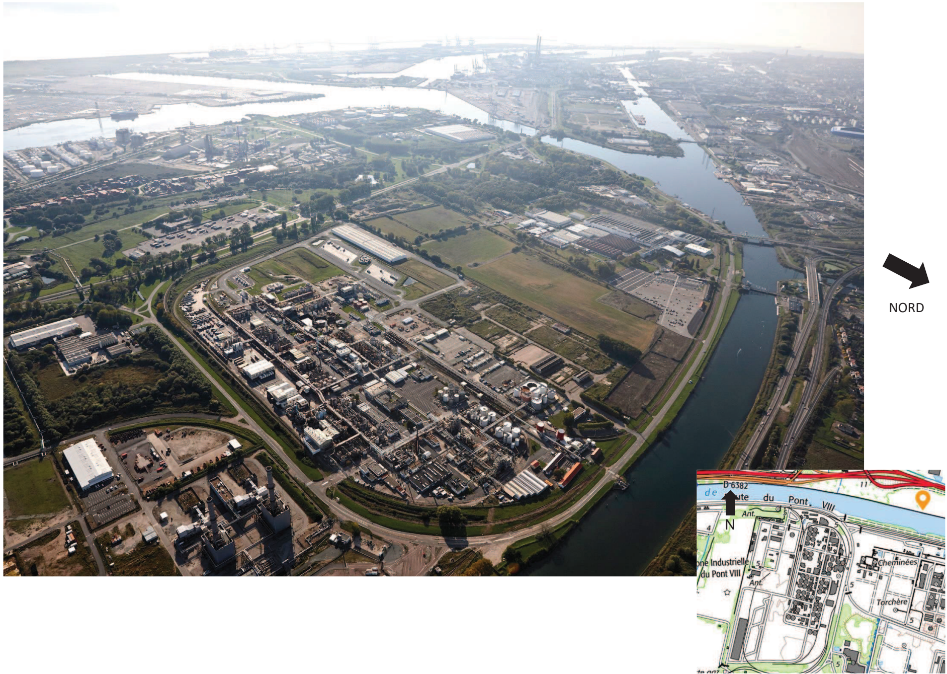
Figure 3 : Vue aérienne avec environnement lointain 2 - Octobre 2017
