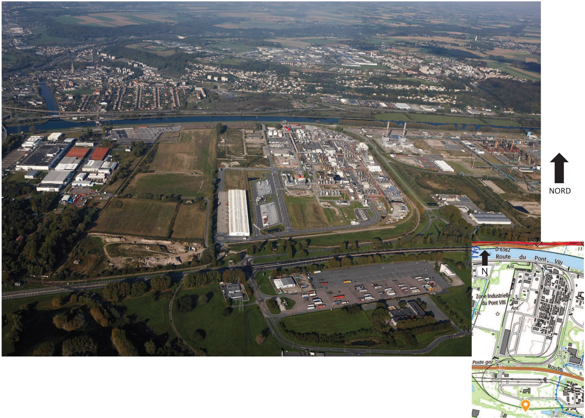
Figure 2 : Vue aérienne avec environnement lointain 1 - Octobre 2017
