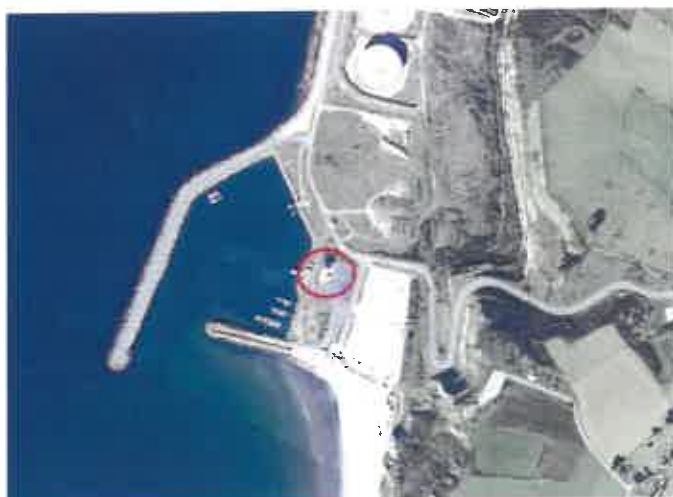
Figure 2 : Toit concerné sur la zone d'Antifer
