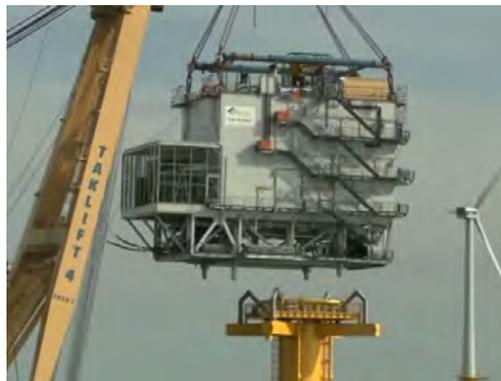
Dépose de la plateforme (Belwind video)
