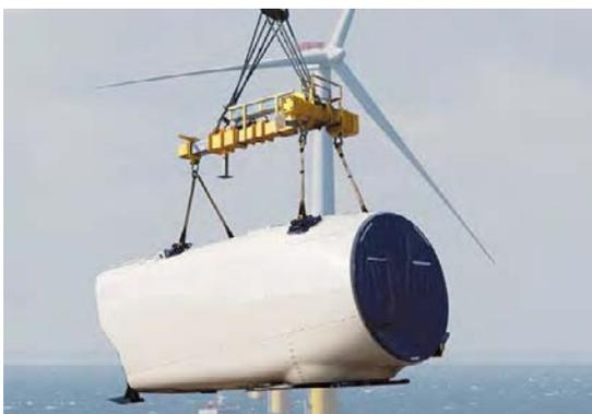
Dépose de la nacelle ([www.fk-wind.dk](http://www.fk-wind.dk))
