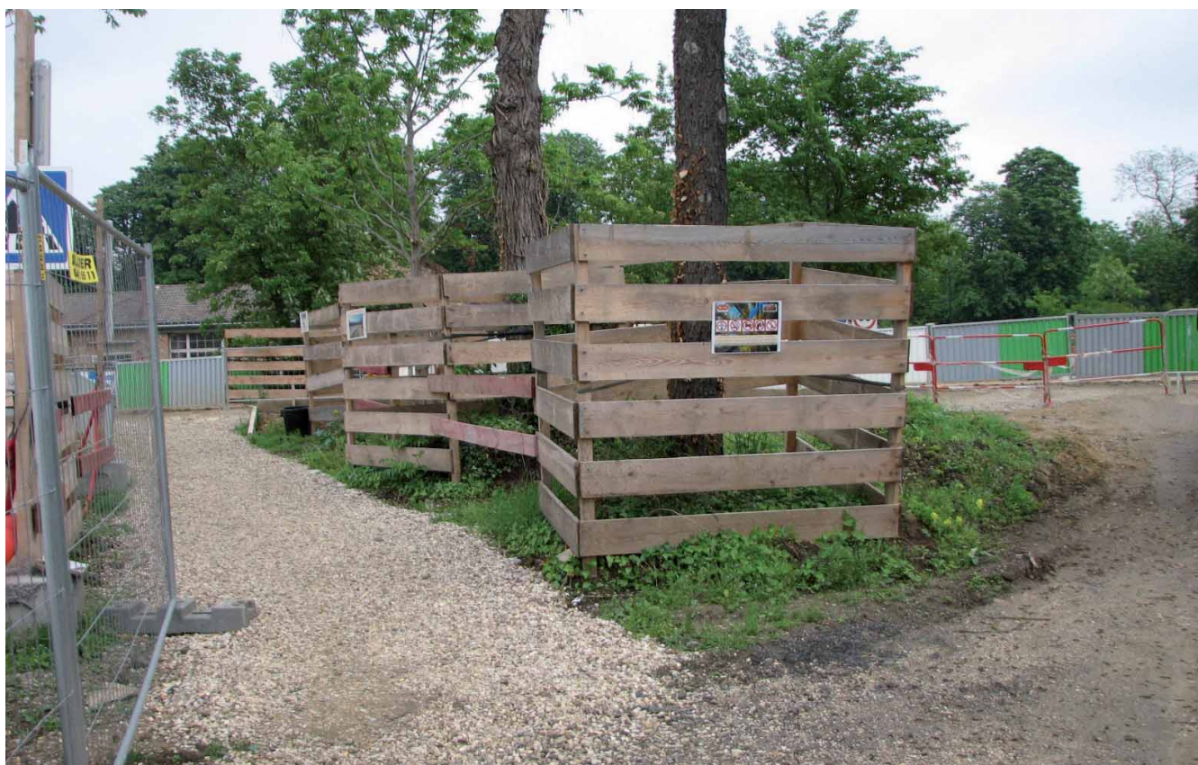
Les démarches de « chantiers verts » prévoient notamment la protection des arbres et de la végétation existante.
