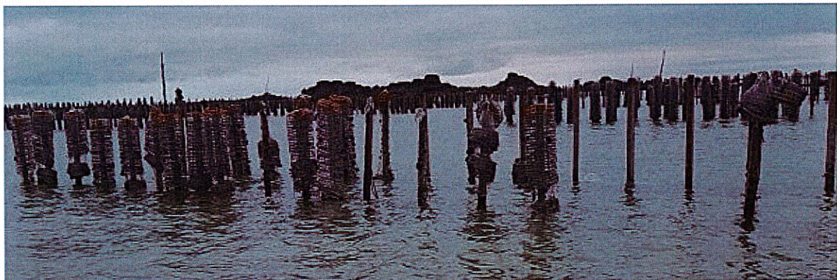
Figure 12 : pertes (moules, protections et pieux) suite à une tempête
