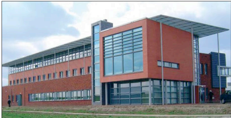
Une gamme étendue de matériaux possibles : bois, briques, béton, bardage métallique. Le bois et la brique sont utilisés principalement sur les constructions les plus visibles depuis l'espace public.
