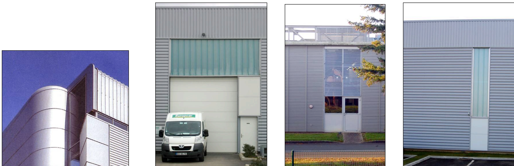
Les bardages métalliques sont utilisés dans une composition mêlant les verticales et les horizontales.
