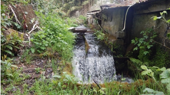
Photo 2: chute d'entrée sur la pisciculture
