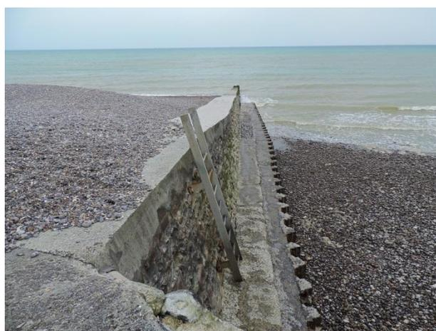
*Epi le plus à l'est : galets affleurant sur la gauche et palplanches apparentes à droite*
