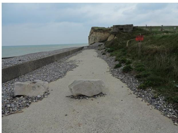
*Accumulation de galets de l'autre côté du mur.
