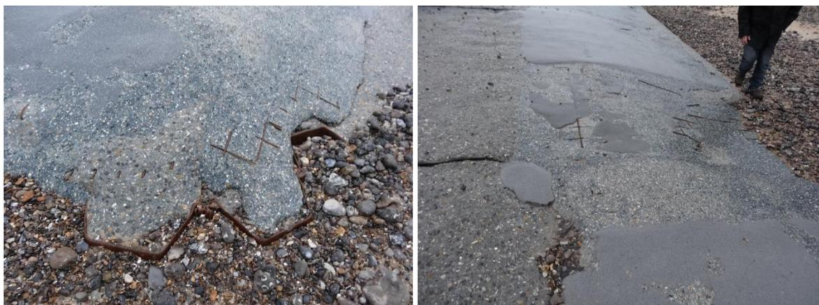
**Fig. 13. Traces d'usures sur la cale – Armatures et palplanches apparentes**
