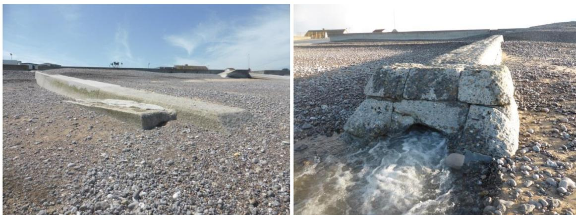
**Fig. 15. Photographies d'un épi et de l'épi buse (ARTELIA, 2018)**
