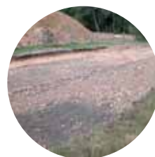
Opération d'étrépage (décapage très léger) afin de rajeunir une friche silicicole Carrière CBN - Yville-sur-Seine
