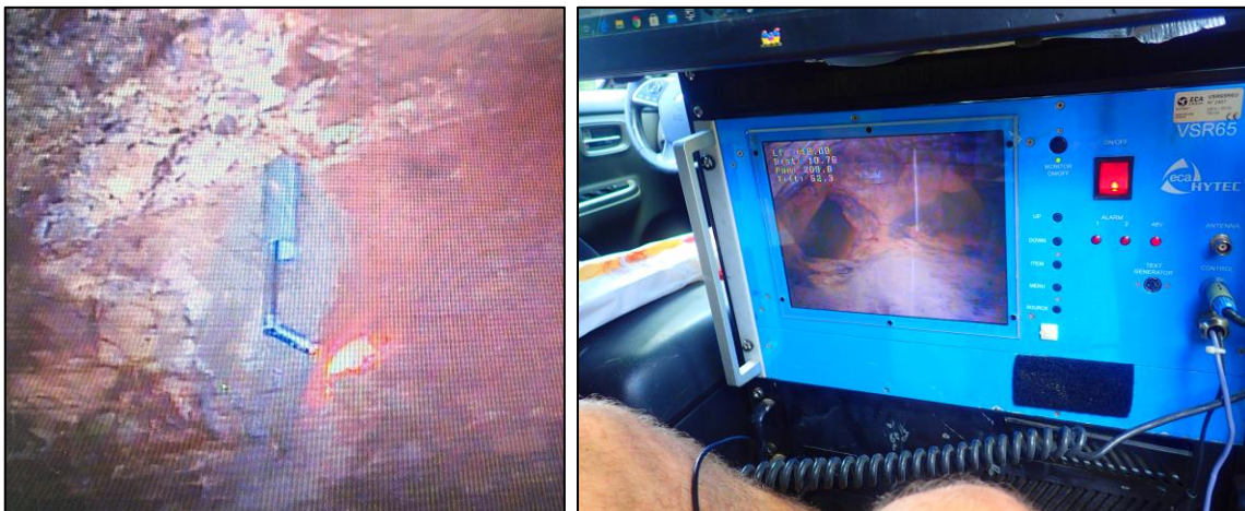
Figure 6 : Inspection vidéo-laser à partir de la surface.
