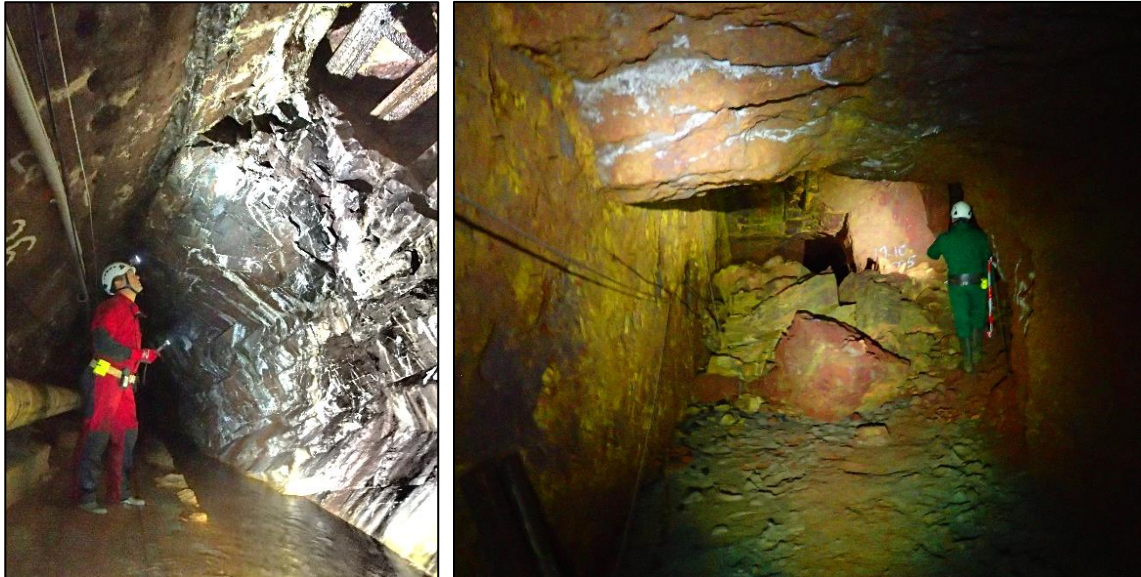
Figure 5 : Inspection visuelle par le fond.
