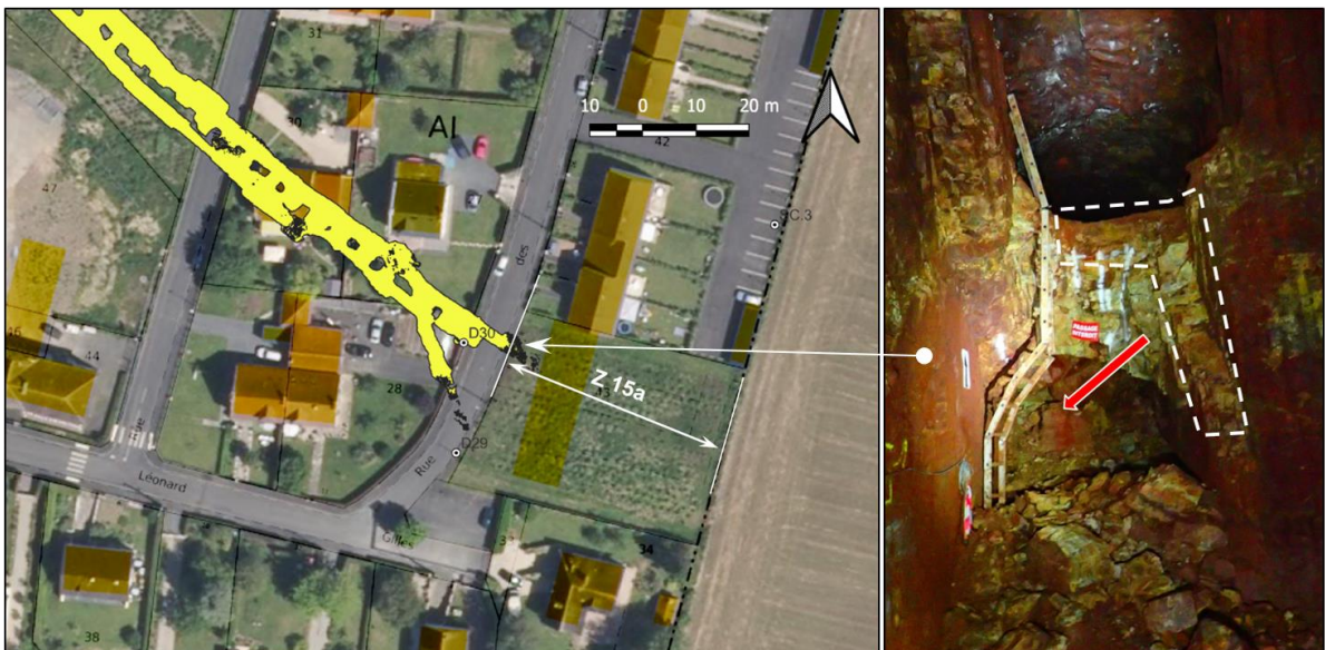
Figure 16 : Flanc nord, cote 1175, accès à la zone 15a, chute d'un bloc métrique.
