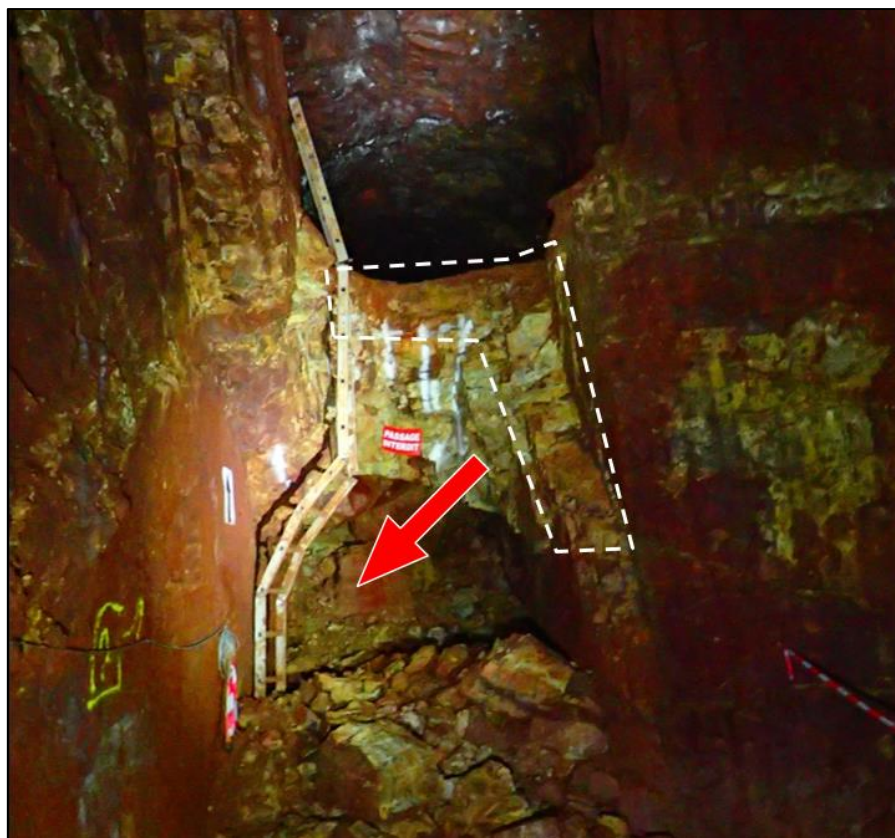
Figure 12 : Chute de bloc à la cote 1175.
