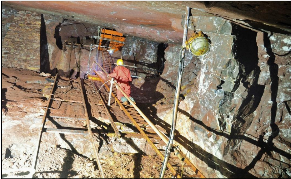
Illustration 5 : Inspection visuelle par le fond.
