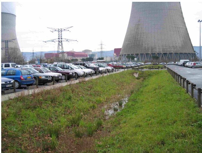
Noue de récupération et stockage d'eaux de ruissellement de parking – CRUAS ( Safège Romans)
