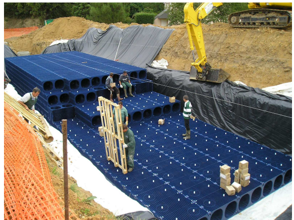
Bassin en caissons WAVIN – Lotissement à Chatillon sur Loire ( Safege Orléans)
