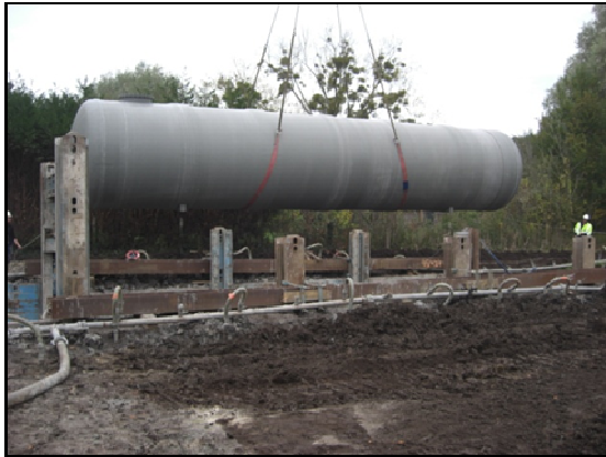
Exemples de cuves de stockage associées aux postes de refoulement de Saint Jean Le Thomas et de Sainteny(50)
