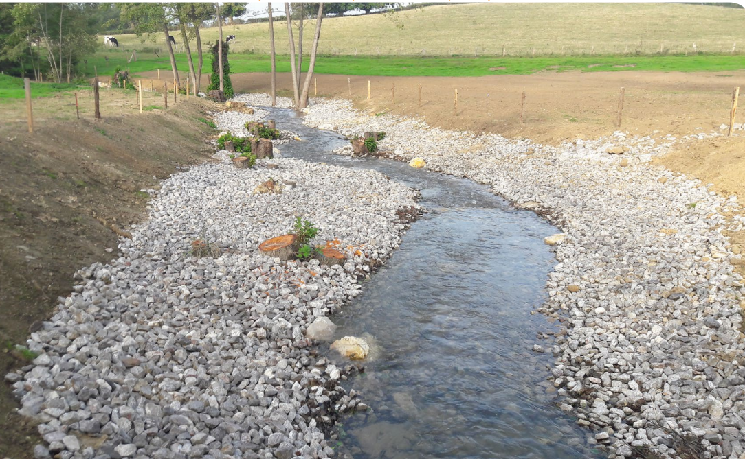
La Béthune au pont de Glinet (Seine-Maritime), réception des travaux en octobre 2016
