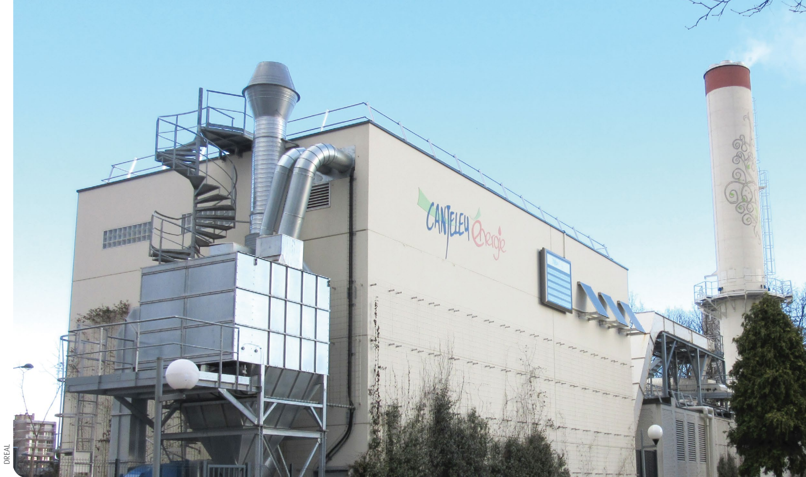
Chaufferie Biomasse à Canteleu (Seine-Maritime)
