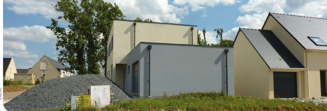
Construction d'un lotissement à Fontaine-Étoupefour (Calvados)
