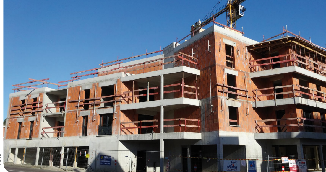
Construction de logements à Lillebonne (Seine-Maritime)
