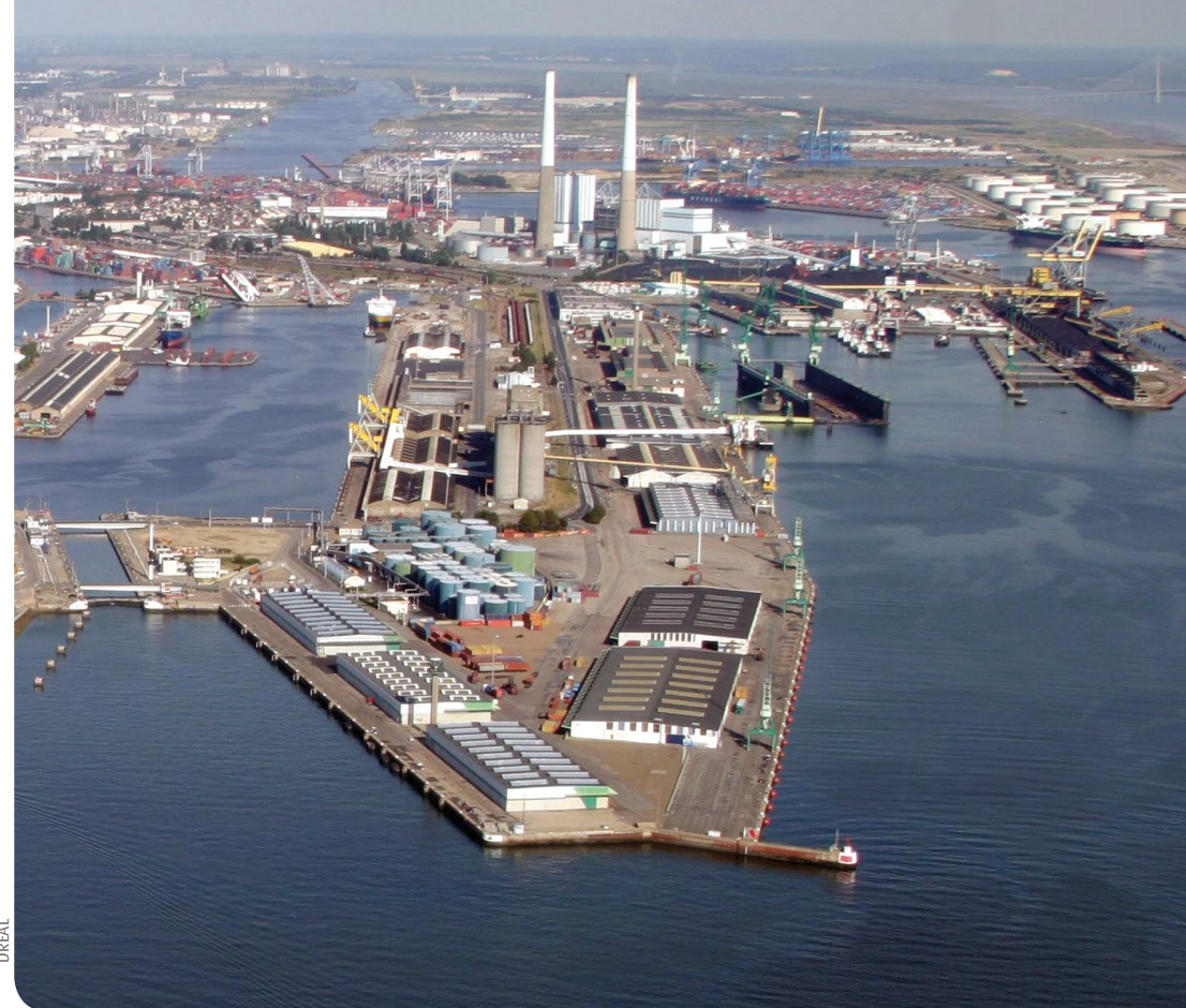
Zone portuaire du Havre (Seine-Maritime)
