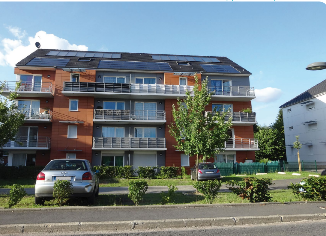
Panneaux solaires sur un immeuble à Malaunay (Seine-Maritime)
