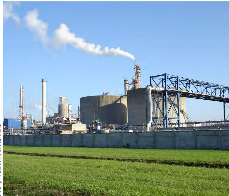
Usine Boréalys dans la zone industrialo-portuaire de Petit-Quevilly et Grand-Quevilly (Seine-Maritime)
