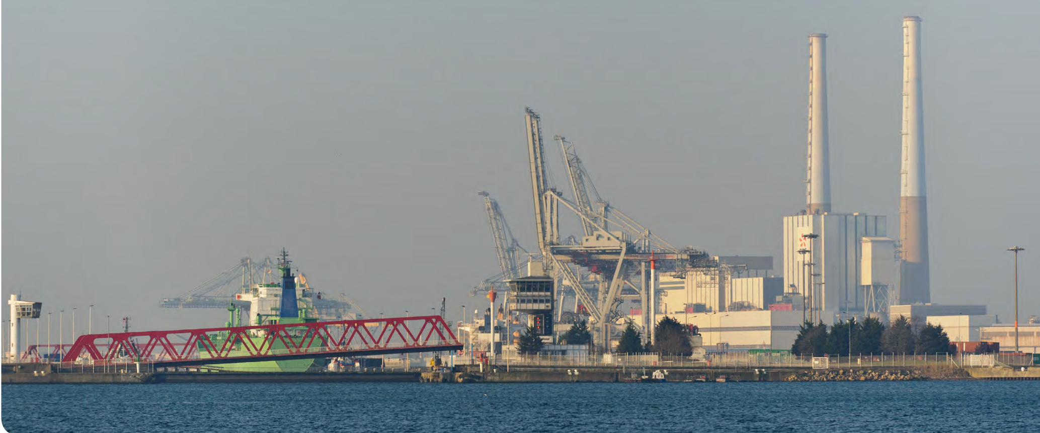
Grand Port Maritime du Havre (Seine-Maritime)
