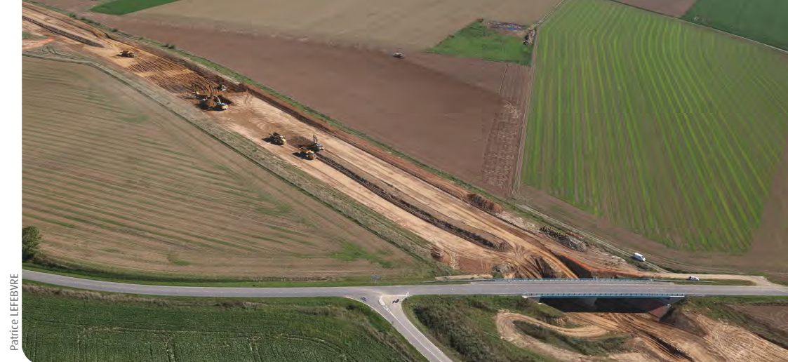
Travaux de terrassement de la RN 27
