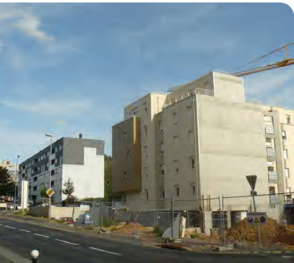
Construction de logements collectifs à Caen (Calvados)
