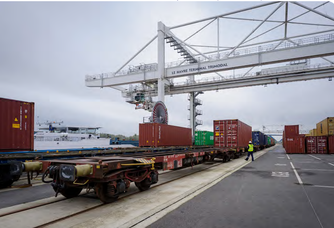
Plateforme multimodale située au cœur du port du Havre (Seine-Maritime)
