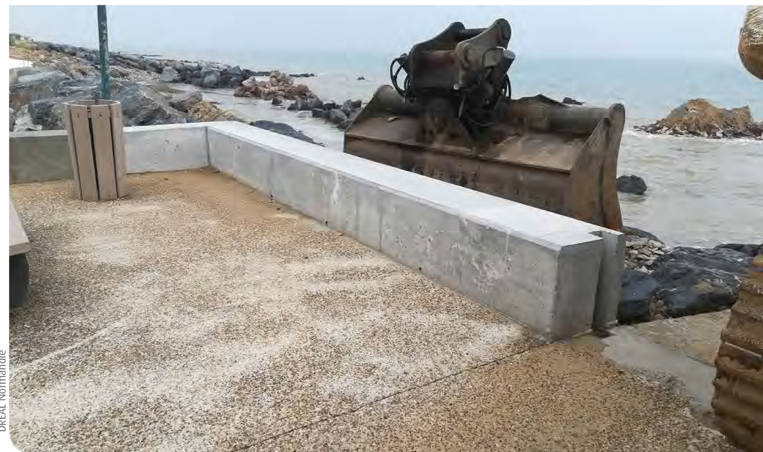
Digue reconstruite de Ver-sur-Mer (Calvados)
