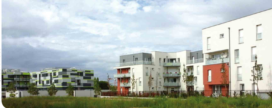
Logements collectifs à Vernon (Eure)
