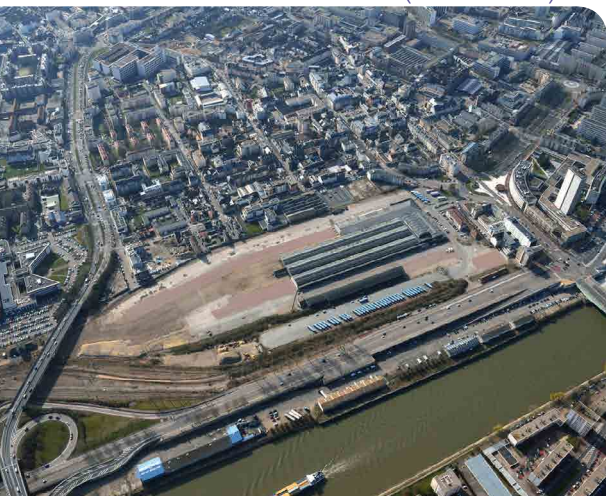
Tranchée ferroviaire couverte de Rouen (Seine-Maritime)
