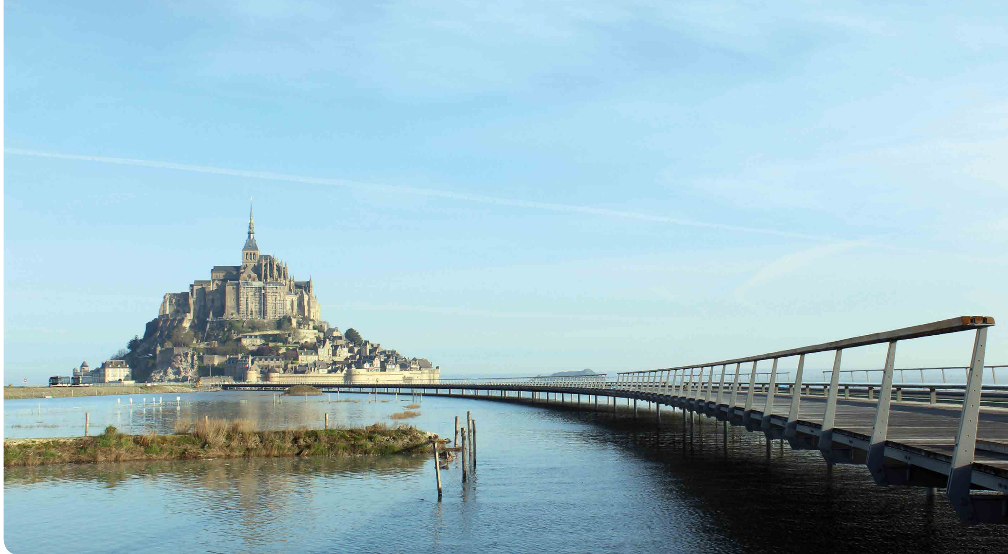
Passerelle d'accès au Mont-Saint-Michel (Manche)
