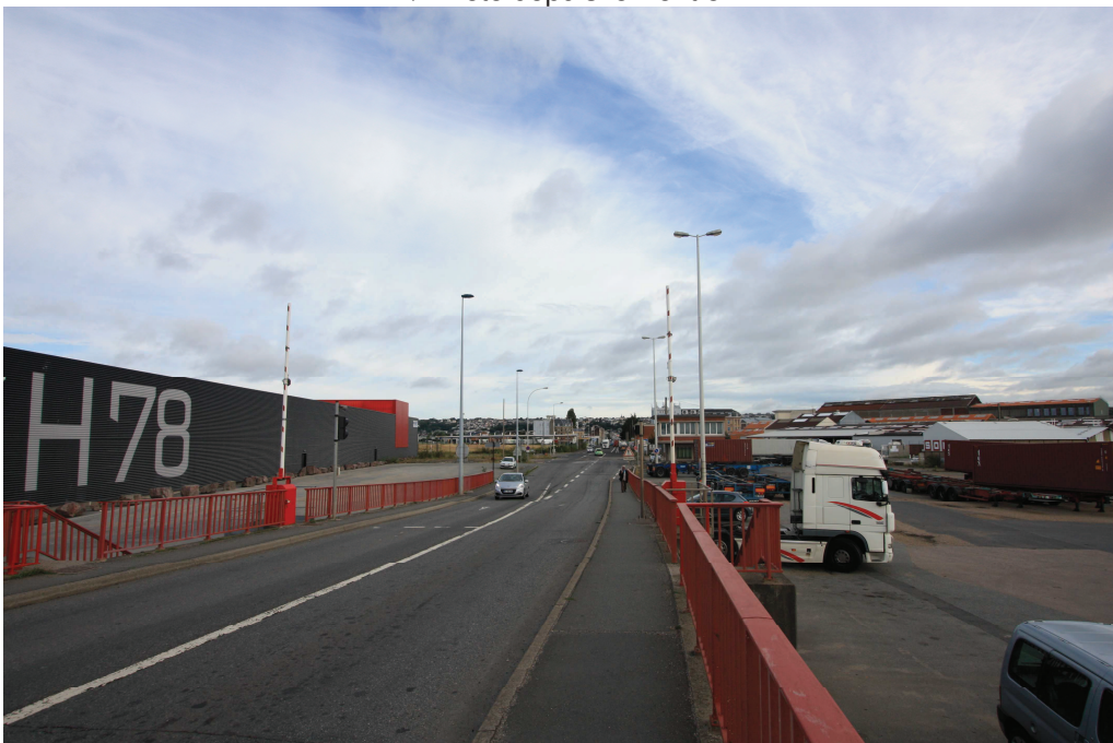
2/ Photo depuis le Pont 5
