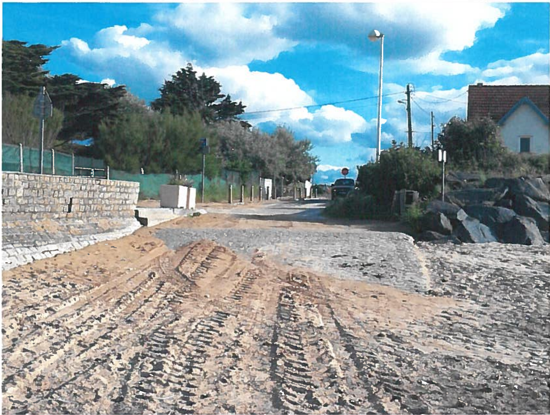
Photo 11 – vue cale VC2 du Marais côté mer
