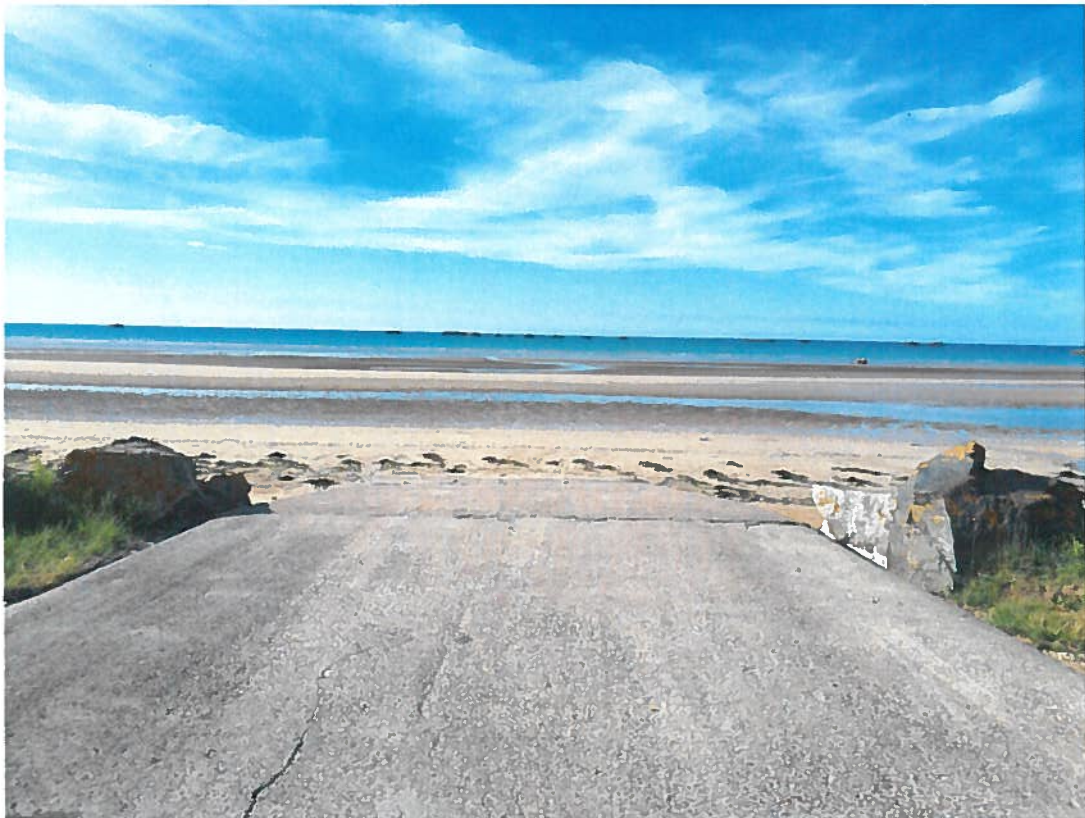
Photo 4 – vue cale du chemin du Rotoir côté terre
