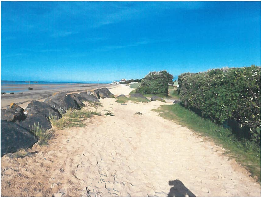
Photo 9 – vue actuelle cale allée du Large côté Ouest
