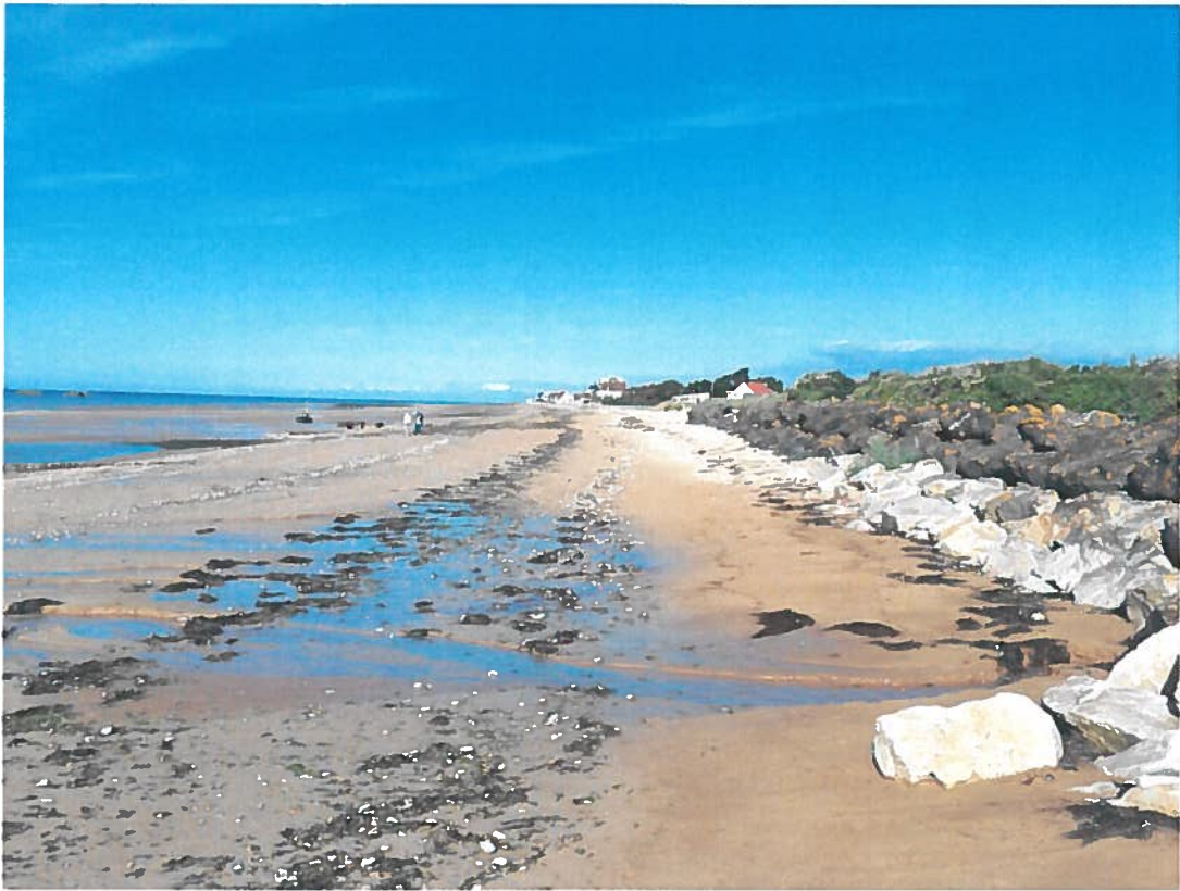
Photo 5 – vue lointaine cale allée du Large depuis cale du chemin du Rotoir côté mer
