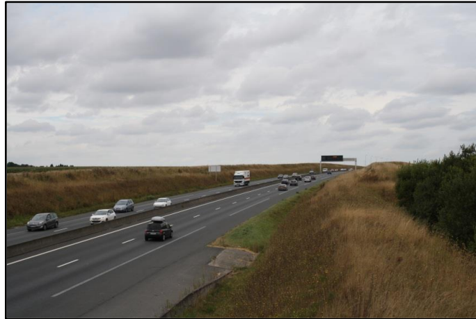
Fig. 14. RN814 encaissée sur Louvigny (source : Rapport de présentation – PLU de Louvigny)
