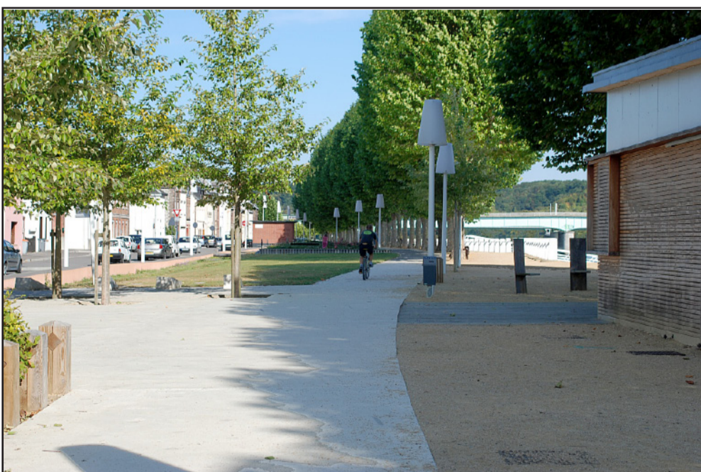
Ce réaménagement récent des quais de Seine à Oissel a permis à la ville de retrouver un contact et des usages avec le bord de l'eau. Le choix du mobilier résolument contemporain est adapté à ce contexte urbain.
