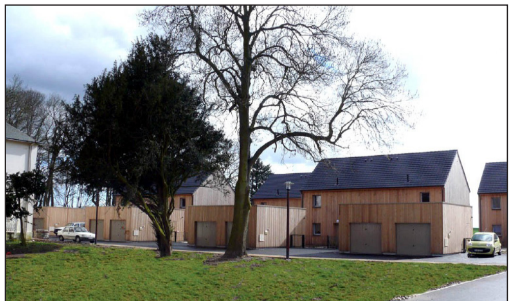
Une extension urbaine en plein coeur de village à la Neuville-Chart d'Oisel. Un habitat dense et contemporain respectant la volumétrie traditionnelle des constructions existantes. (Cliché CAUE 76)
