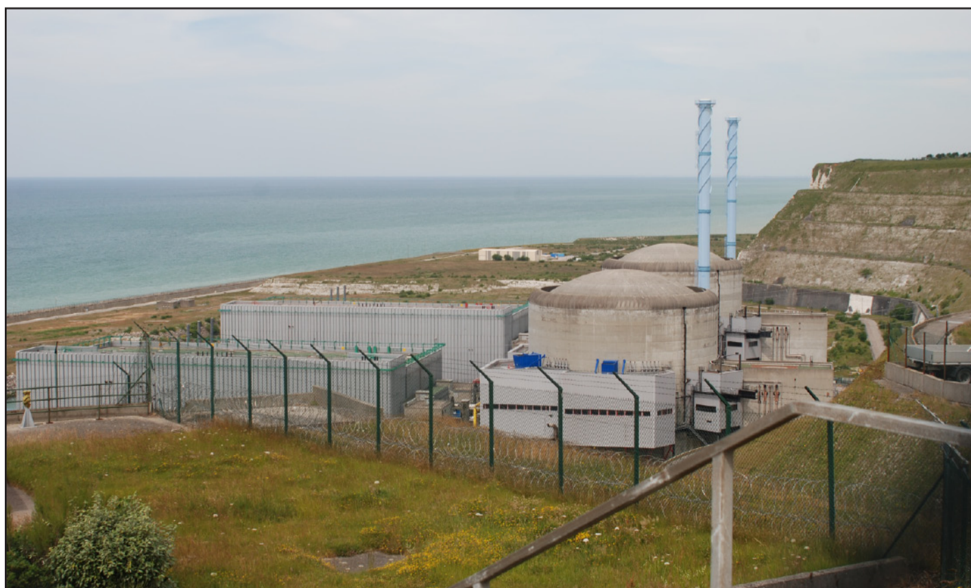
Centrale nucléaire de Penly.
