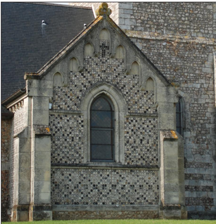
La façade de l'église de Mélamare est construite à partir d'un assemblage de silex formant une mosaïque mêlant différentes nuances de couleurs. Ce remplissage des façades est très courant dans le pays de Caux, région dans laquelle le calcaire est rare et réservé aux chaînages.
