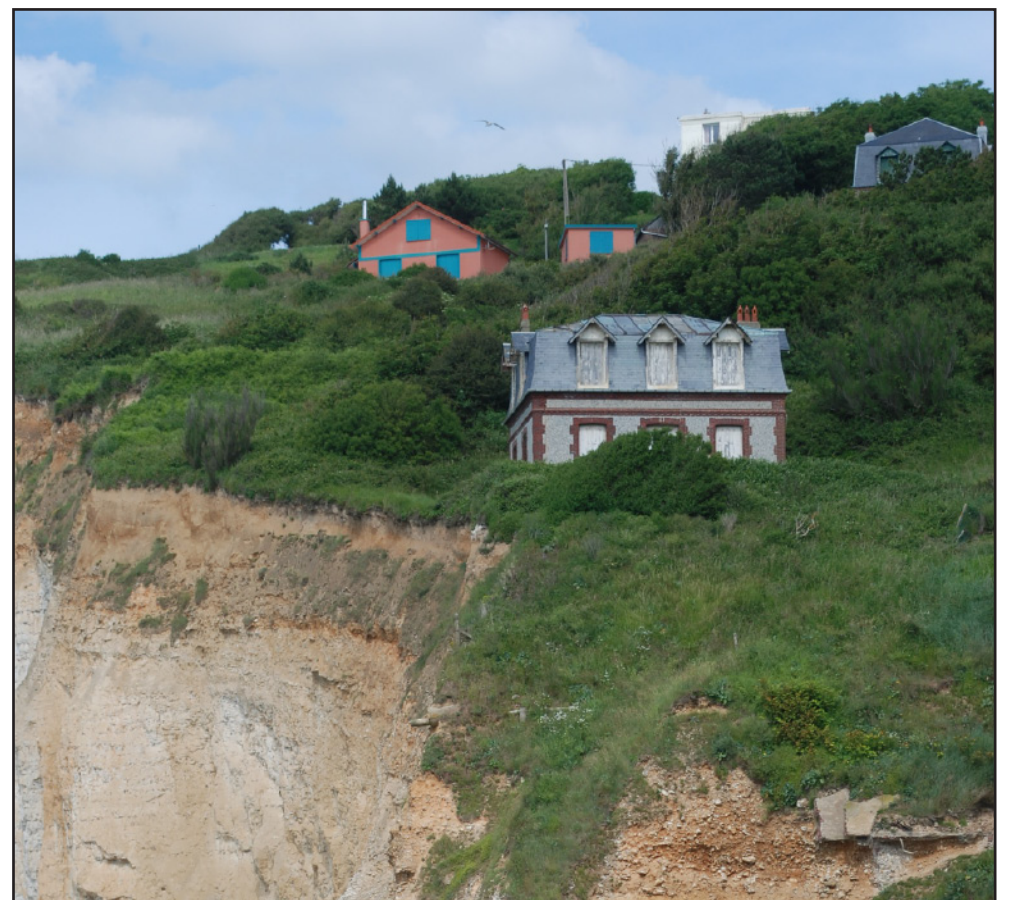
Cette maison sur le haut de la falaise n'est plus habitable en raison des risques très élevés d'effondrement.
