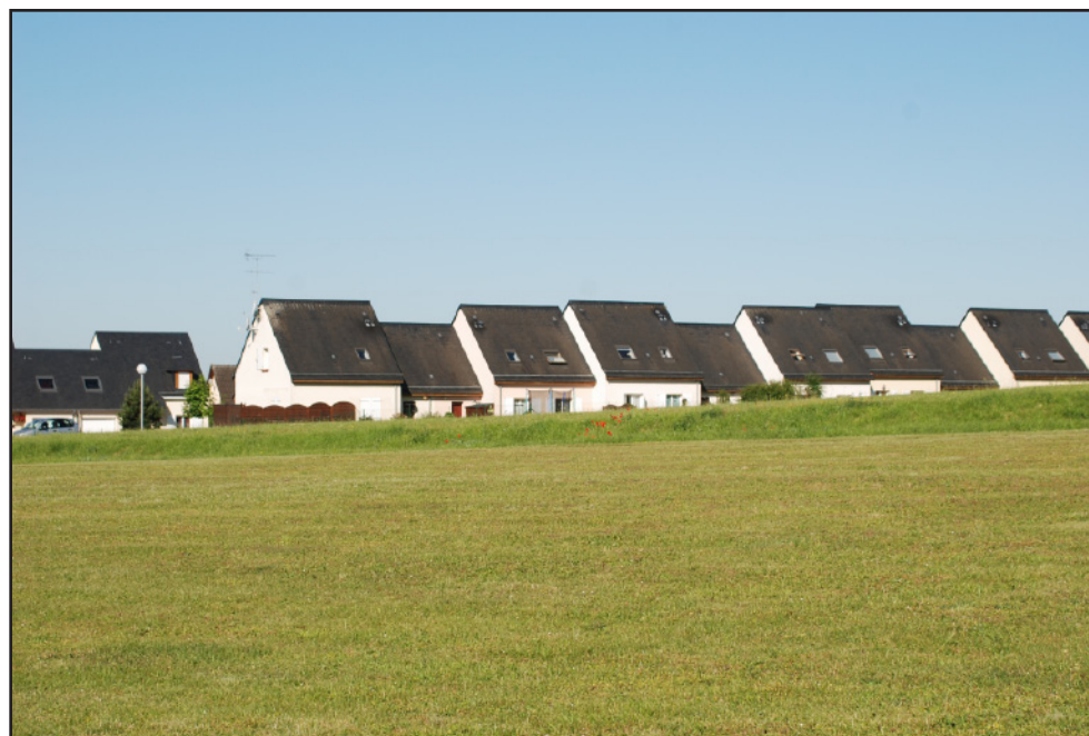
Un lotissement aux portes de Pacy-sur-Eure, une forme urbaine standardisée et sans identité. (2009)
