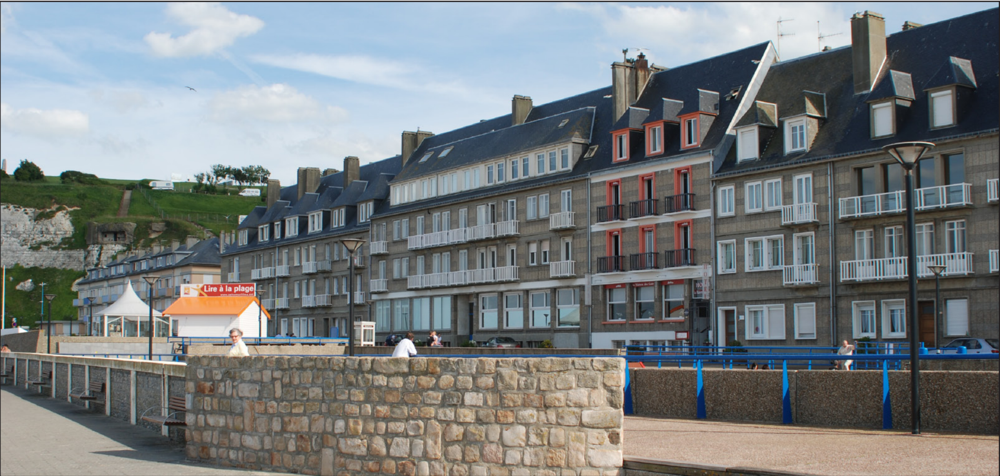
Front de mer reconstruit à Saint-Valéry-en-Caux.
