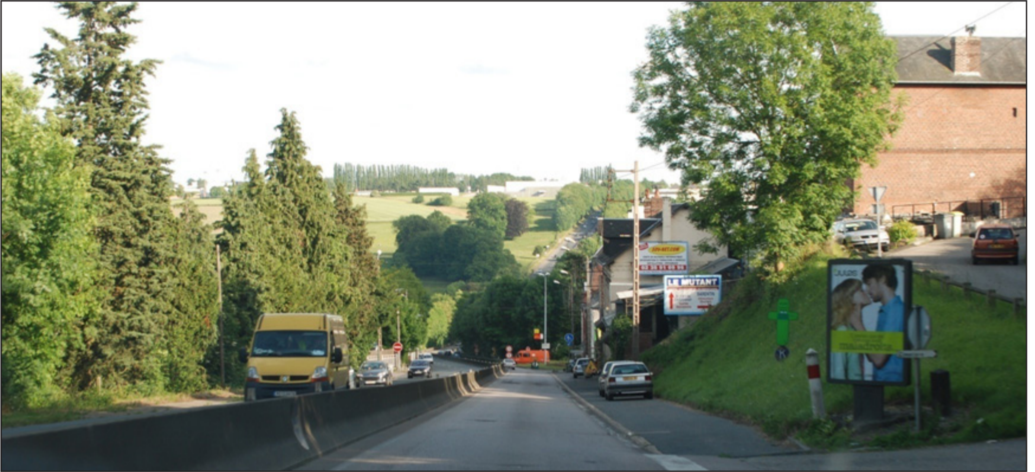
Entrée de ville de Barentin par la RD 6015. (2009 - commune de Barentin)
