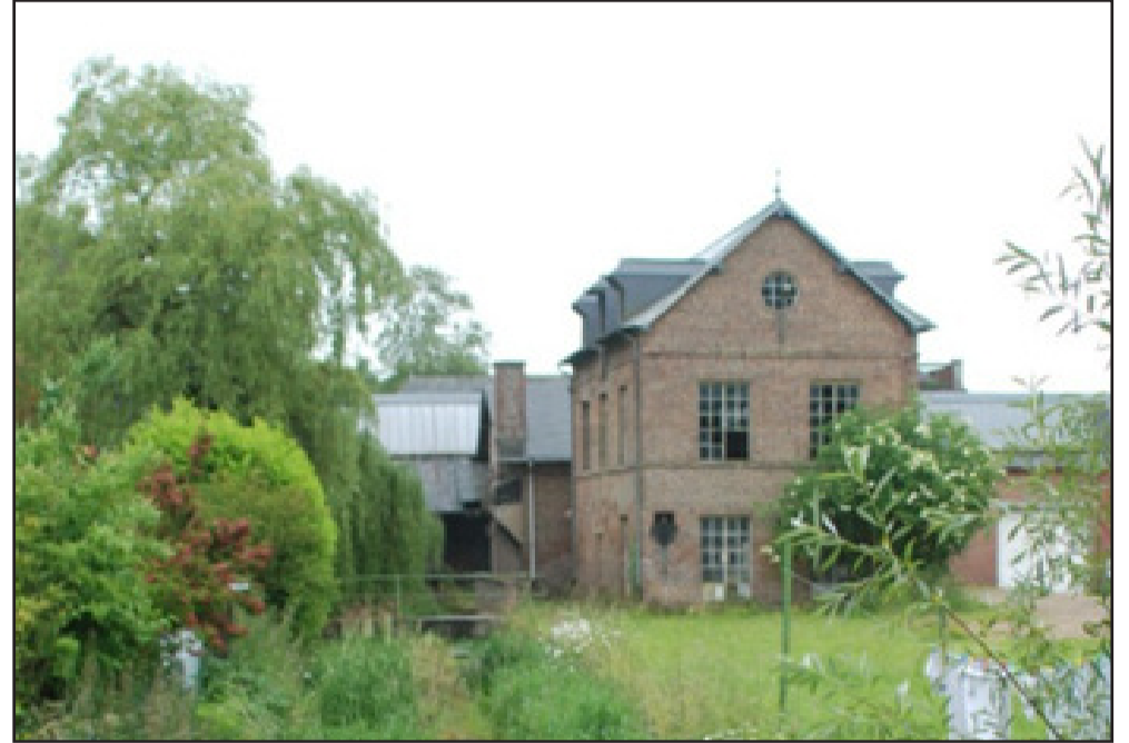
Ancienne usine en friche à Saint-Austreberthe : un site et des bâtiments qui méritent d'être restauré pour sa valeur patrimoniale. (2009)
