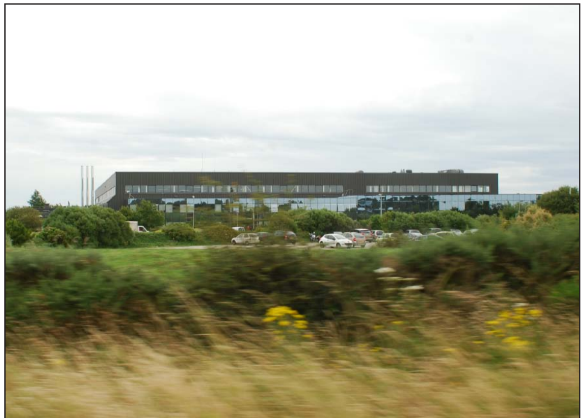
Une zone d'activités exemplaire : bâtiments sombres et discrets, forte présence végétale aux abords, recul par rapport à la voie.(ZA le Calvaire à Edreville)
