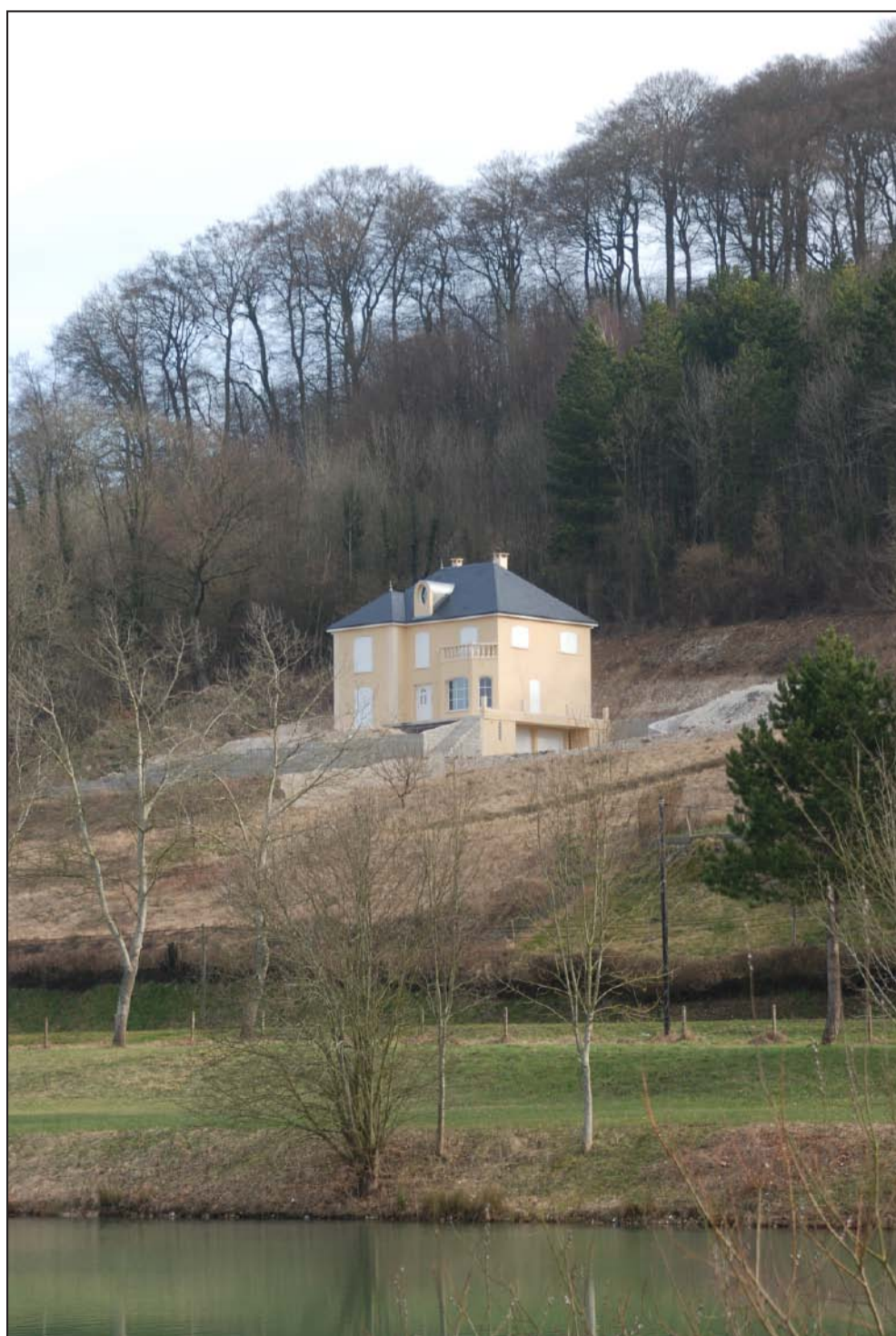
A la Frenaye, les maisons isolées dans la pente entraînent de lourds terrassements qui abîment sérieusement les coteaux. (2010 - commune de Saint-Hellier)
