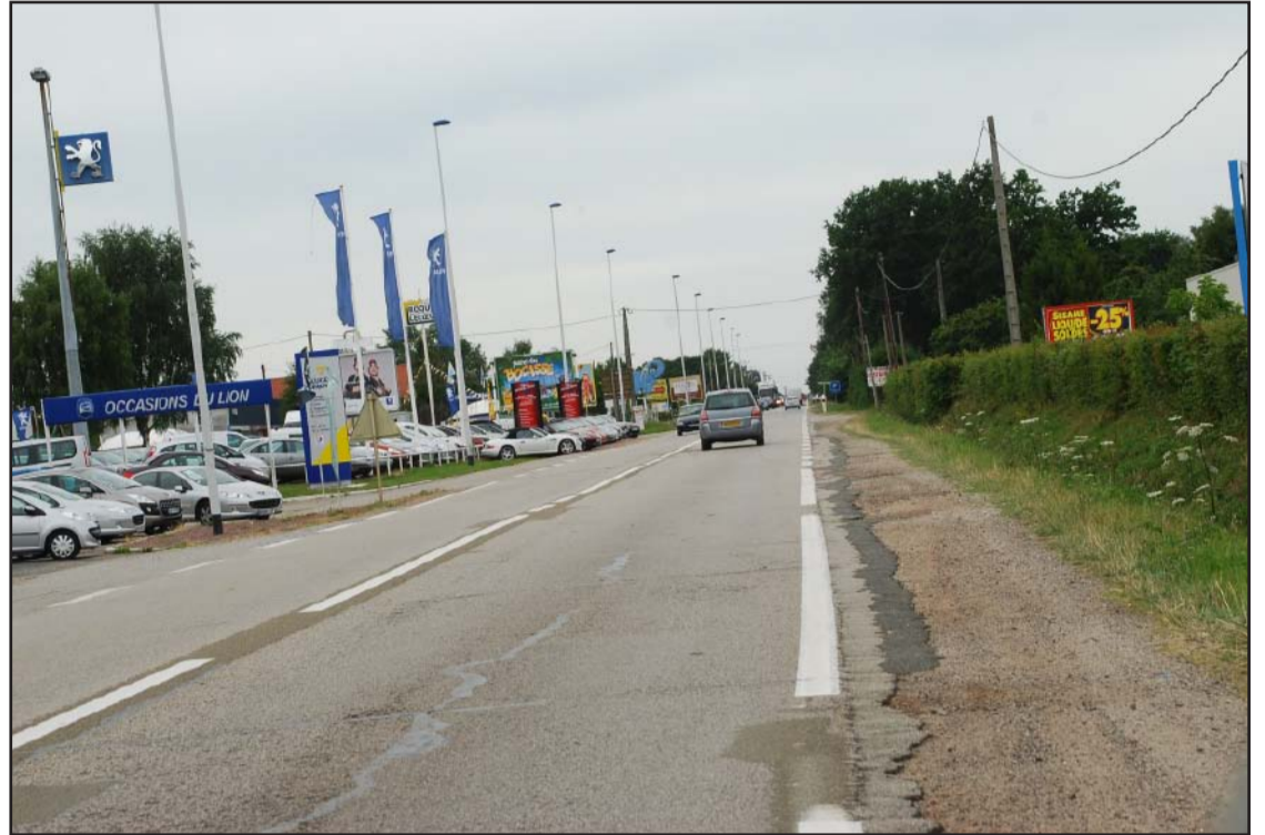
Une entrée de ville dégradée.
