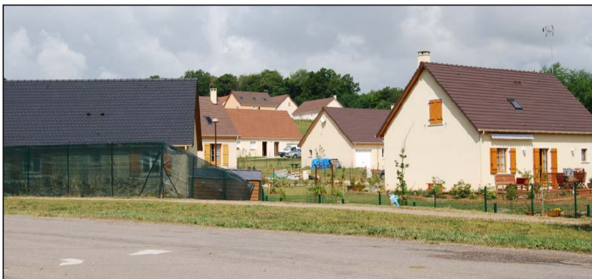
D'architecture banale, ces constructions récentes sont peu denses et mal implantées dans la pente du coteau.
