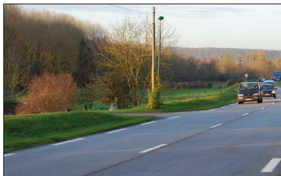
La RD 5 à proximité de Sainte-Geneviève-les-Gasny. (2009)
