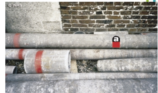
Dans les canalisations en amiante-ciment
