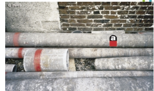
Dans les canalisations en amiante-ciment
