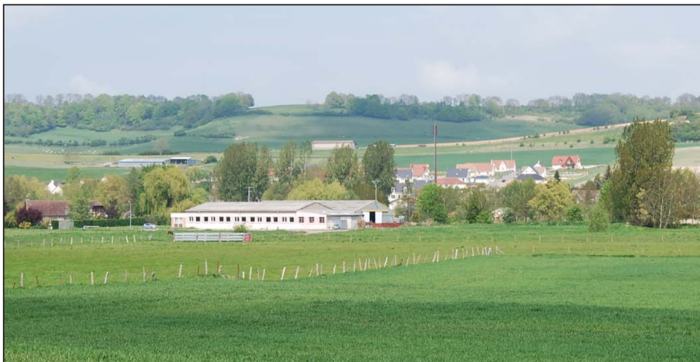
Bâtiments agricoles trop clairs et absence d'un enclos végétal.
