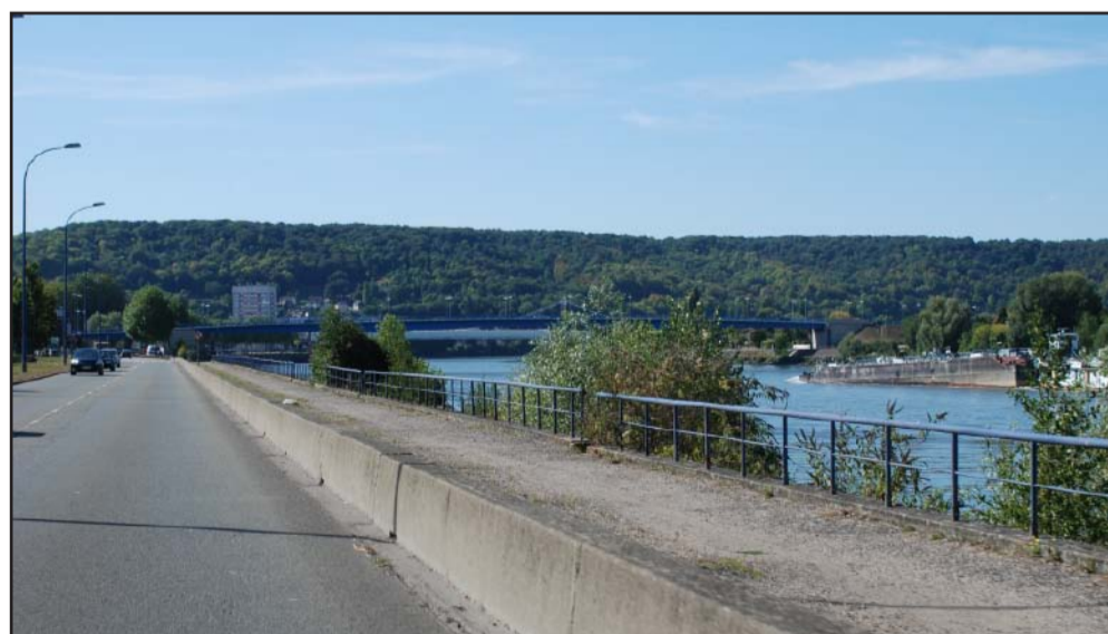
Des quais très minéralisés et peu valorisants à l'entrée d'Elbeuf.
