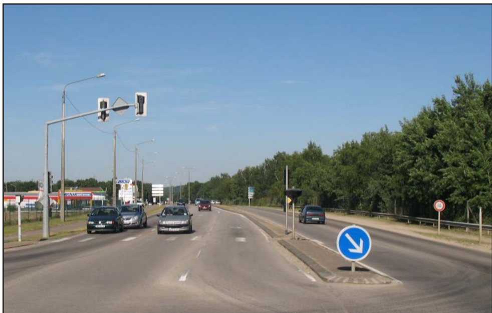
La RD 7 au niveau de Cléon : une image très routière au coeur de la boucle. (2009 - commune de Cléon)
